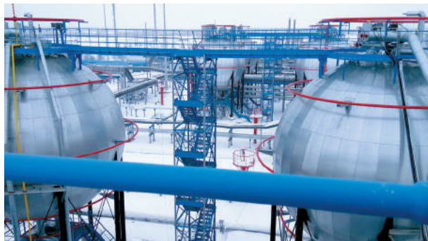
Шаровые резервуары объемом 600 м 3 для хранения деэтанализованного конденсата на Уренгойском ЗПКТ, 2-я очередь (Газпром)
