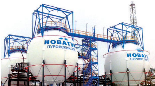
Парк хранения ШФЛУ на площадке Пуровского ЗПК (НОВАТЭК). Шаровые резервуары объемом 600 м 3
